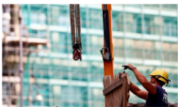
Lavori in un cantiere
